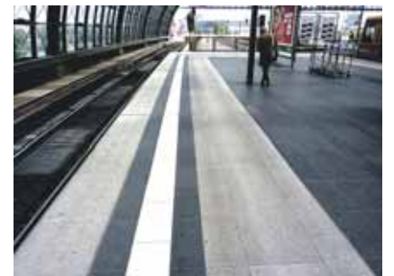
So ist ein korrekt ausgeführtes Leitsystem in Berlin für blinde und sehbehinderte Passanten von Nutzen
