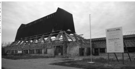
Mendelsohns Hutfabrik – Rekonstruktion der Färberei mit dem „Hut“
