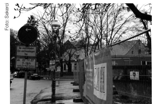
Baustellen rund um die Königsstraße ...
